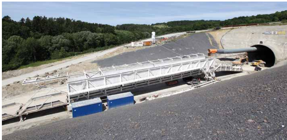
Bild 8. Aufbau der Sohlbrücke VE-Süd.
