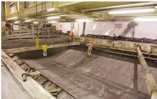
Bild 11. Ausschalen der Seitenschalung im Arbeitsfeld 3.
