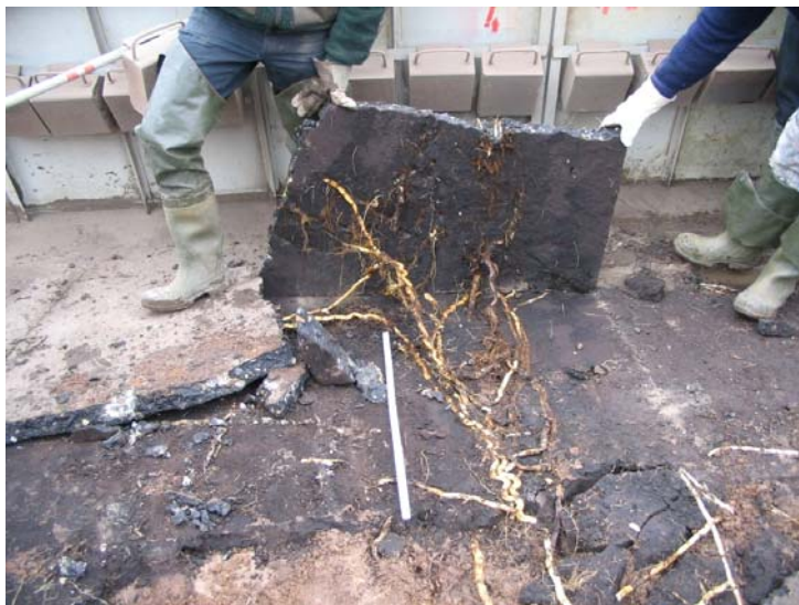
Abbildung 32: Rhizom unter einer 30 Jahre alten Asphaltdeckung ca. 50 cm unterhalb der Wasserlinie (Elbe-Seitenkanal, WSA Uelzen)
