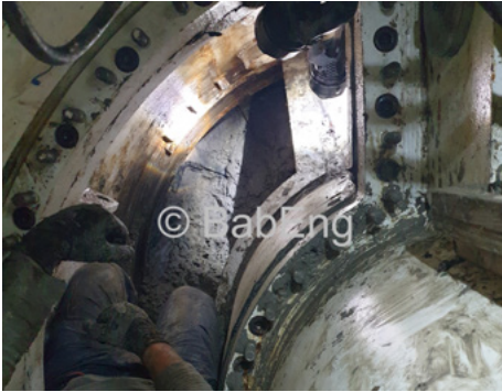
Abbildung 4-1: Zugangöffnung in die Abbaukammer © BabEng
