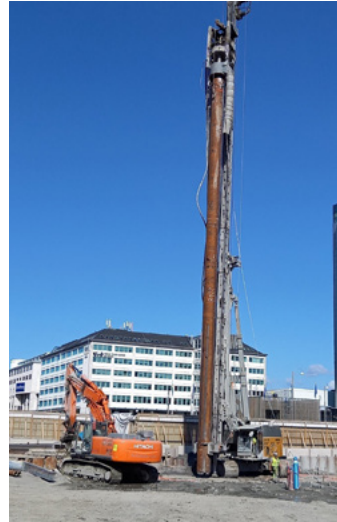
Abbildung 3-7: Bohrgerät mit geladenem Pfahl
