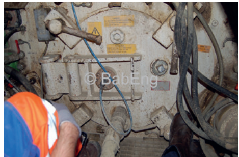
Abbildung 3-1: Zugang zu der Abbaukammer – Vortriebsmaschine mit Zugangstür © BabEng
