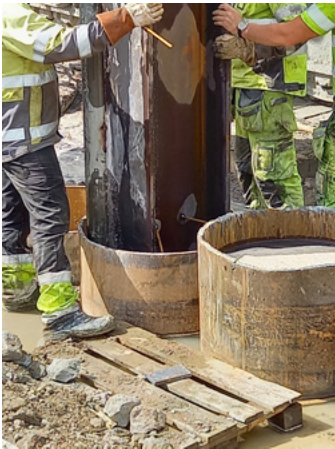
Abbildung 3-8: Nachträgliche Verstärkung der Pfähle durch Einsetzen eines HEB-Trägers
