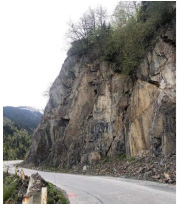
Abbildung 2-2: Straßenanschnitt im Projektgebiet mit steilstehendem Schiefer und Quarzit
