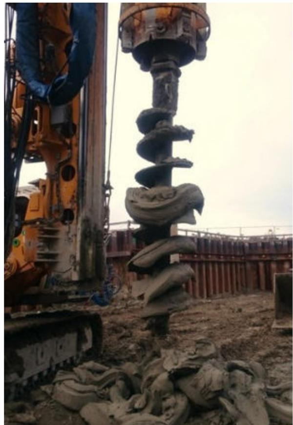
Abbildung 3-3: Verklebte Bohrschnecke (BAUER Spezialtiefbau)
