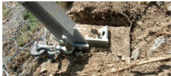
Abbildung 3: Versagen eines Betonfundamentes. Das Schutzziel wurde trotzdem erreicht.
