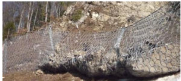
Abbildung 2: Versagen einer Stütze durch Steinerschlag. Das Schutzziel wurde trotzdem erreicht.
