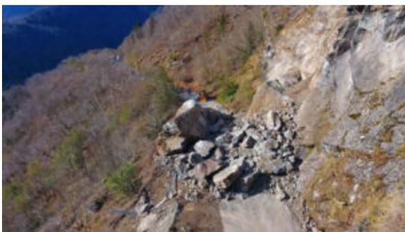
Abbildung 2-1: Felssturzereignis im Dezember 2021 führte zur Blockierung der Straße im Enguri-Tal
