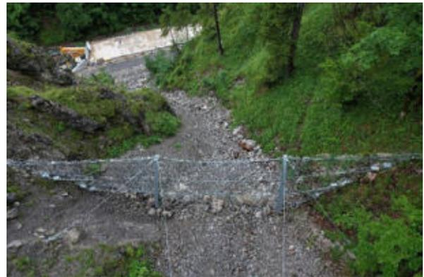
Abbildung 3-1: Drohnenaufnahme des oberhalb der Baustelle im Gerinne installierten Steinschlagsschutzzaunes.
