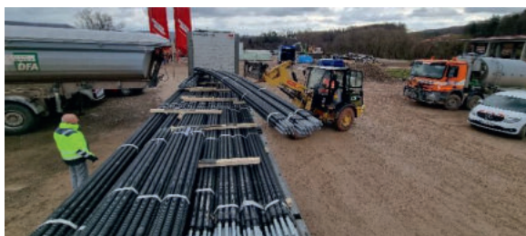
Abbildung 4-1: Doppelt korrosionsgeschützte Tragglieder auf der Baustelle
