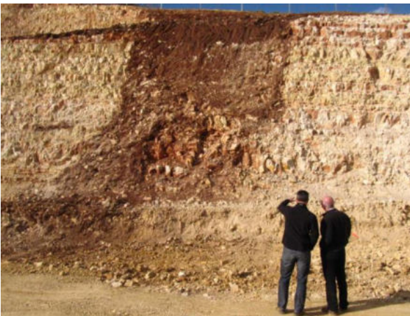
Foto 3-1 Verfüllter Karsthohlraum entlang der Autobahn A1 in der Nähe von Abu Ghosh.
