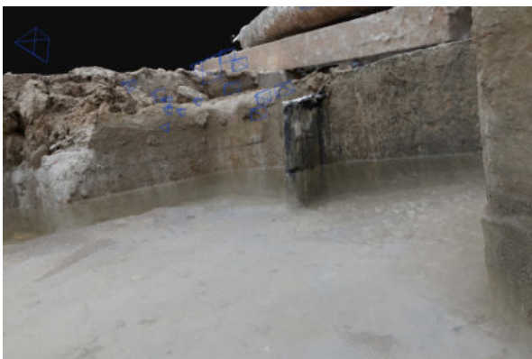
Abbildung 4.2 3D-Modell zweier Schlitzwandlamellen mit eingebautem Fugenband (Schmidt, 2023)
