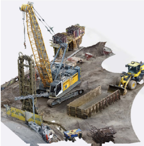
Abbildung 4.1 3D-Modell vom Herstellen einer Schlitzwandlamelle (Schmidt, 2023)
