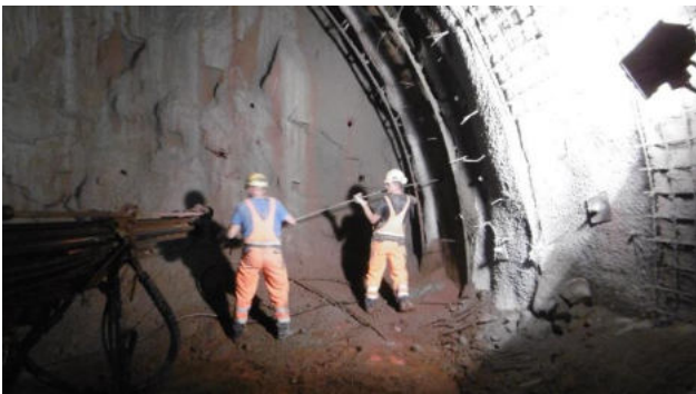
Abbildung 0-1 und 0-2: Einbau eines temporären SN-Ankers im Tunnelbau und Herstellung eines dauerhaften Bodennagelsystems im Zuge einer Böschungssicherung
