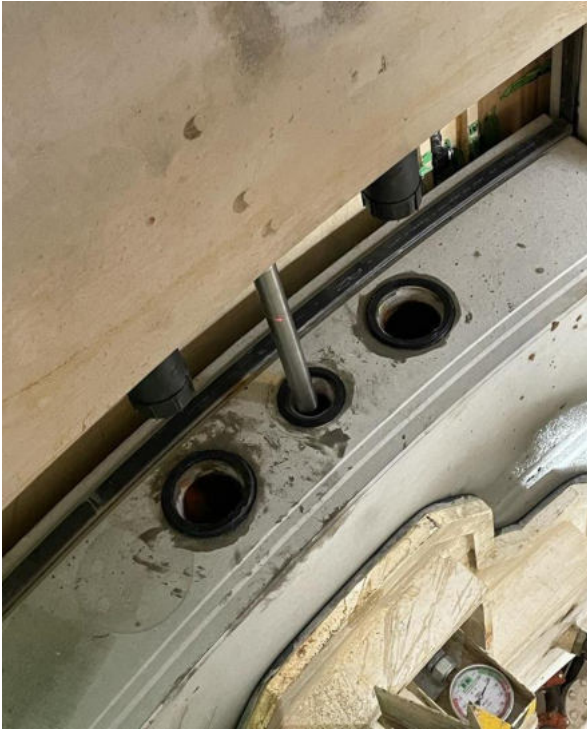
Abbildung 2-10 Ein Sondersegment mit korrosionsgeschützten Scherkraftdübeln und einem Spannstab wird mit der Saugplatte im TBM-Tunnel eingebaut.
