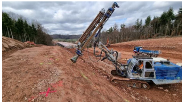
Abbildung 0-1 und 0-2: Einbau eines temporären SN-Ankers im Tunnelbau und Herstellung eines dauerhaften Bodennagelsystems im Zuge einer Böschungssicherung
