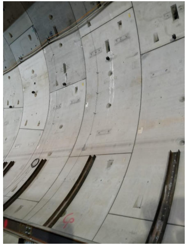
Abbildung 3-1: Eingebaute Sondersegmente Querschlag. Sichtbar sind nur die oberen Vorspanntaschen. Die Stahlprofile unten dienen als Auflager einer späteren Plattform für Vereisungsbohrungen und sind nicht Teil der Abfangkonstruktion.
