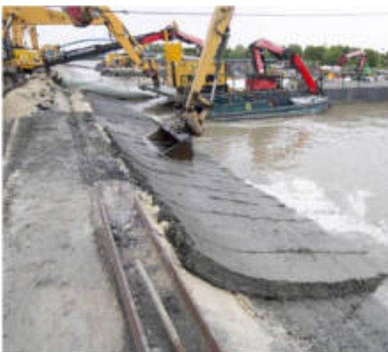
Abbildung 1-1: Unterwassereinbau von Dichtungston an einer Wasserstraße (BAW Archiv)
